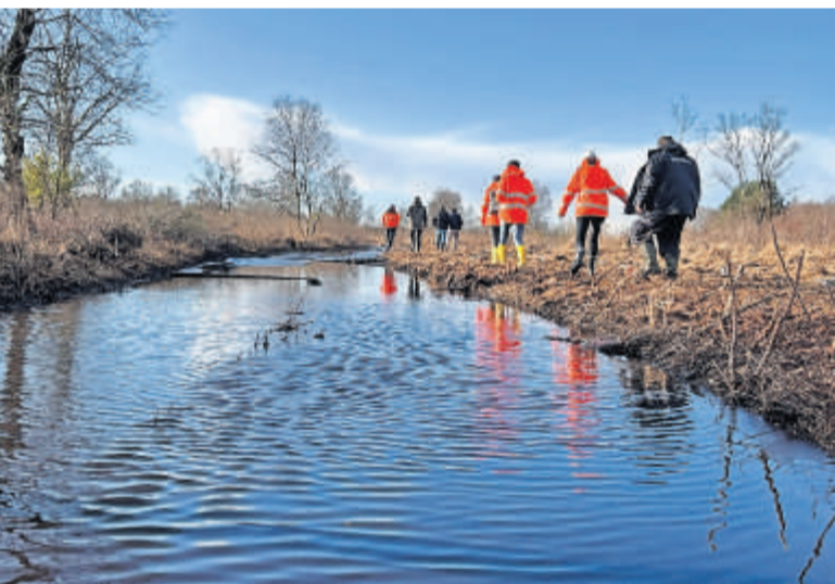
Was hier wie ein Fluss aussieht, ist eigentlich die mit Stahlplatten angelegte Baustellenstraße.
