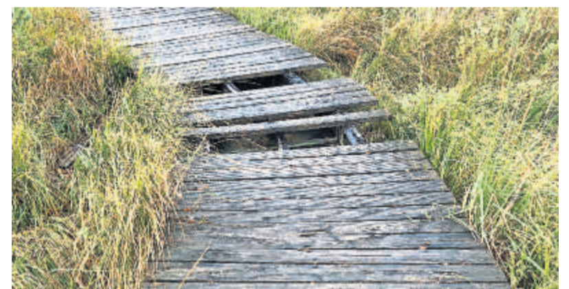
Die Arbeiten am Moorerlebnispfad in Flögeln sind in vollem Gange. Im Bild: So sah der Moorerlebnispfad noch 2019 aus. Bohlen fehlten, der Steg war oftmals an einer Seite abgesackt.
