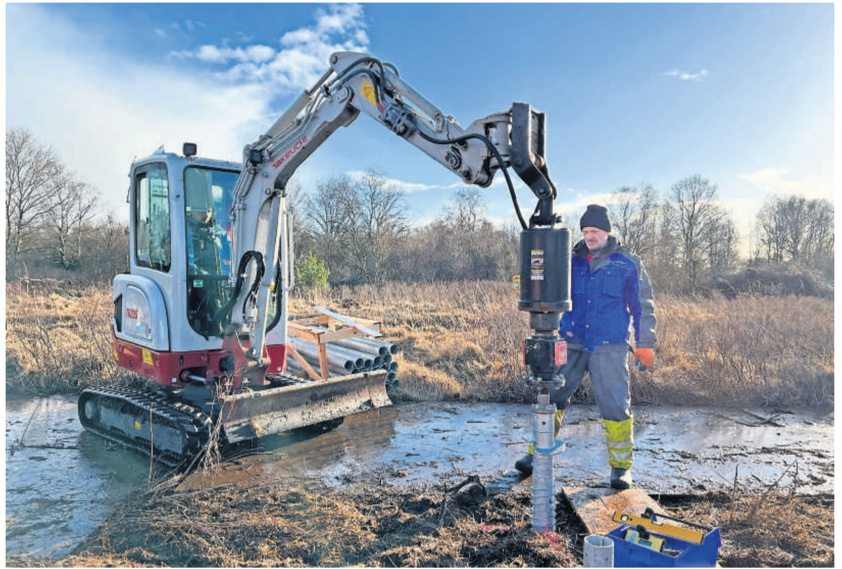
Petr Minarik von der Firma „Deutsche Fundamentbaugesellschaft“ überwacht das Einbringen der Schraubpfähle aus verzinktem Stahl. Fotos: Gallas
