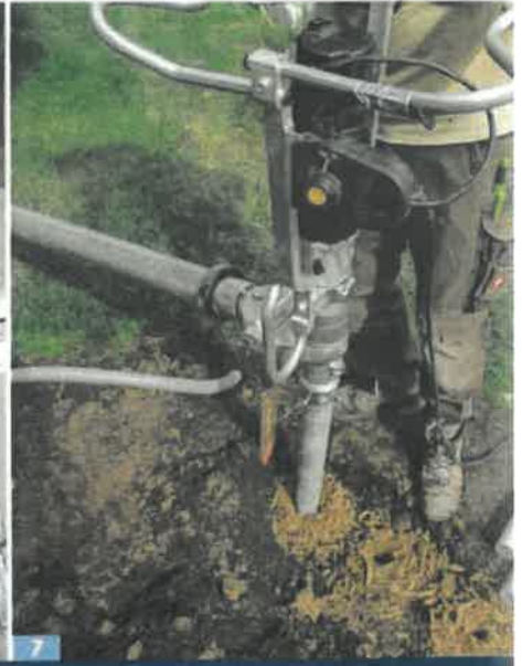
5 bis 8 Ansetzen – Libelle überprüfen – eindrehen – fertig! So setzt man schnell die Fundamente für ein Sichtschutzelement.
