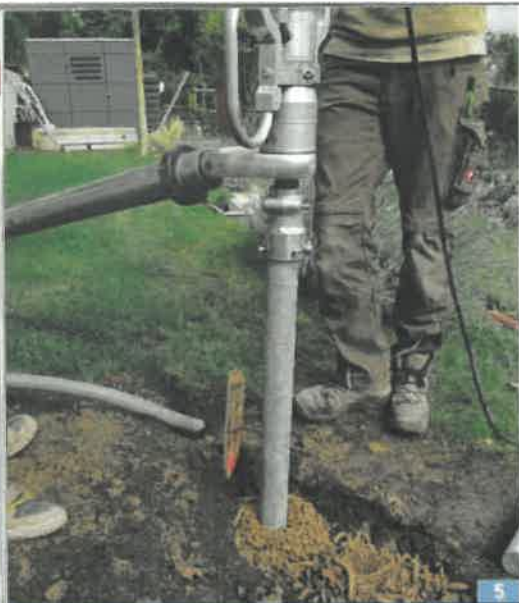
5 bis 8 Ansetzen – Libelle überprüfen – eindrehen – fertig! So setzt man schnell die Fundamente für ein Sichtschutzelement.
